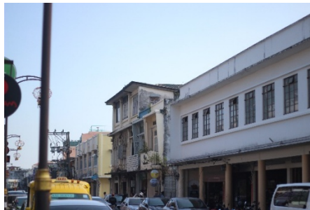
ภาพที่ 2 3 และ 4 สถาปัตยกรรมตึกเรือนแถวแบบชิโน-โปรตุกีสในจังหวัดระนองบริเวณชุมชนบางสำน ตลาดเก่า ในจังหวัดพังงา บริเวณเมืองเก่าตะกั่วป่า และในจังหวัดภูเก็ตย่านเมืองเก่าภูเก็ต
